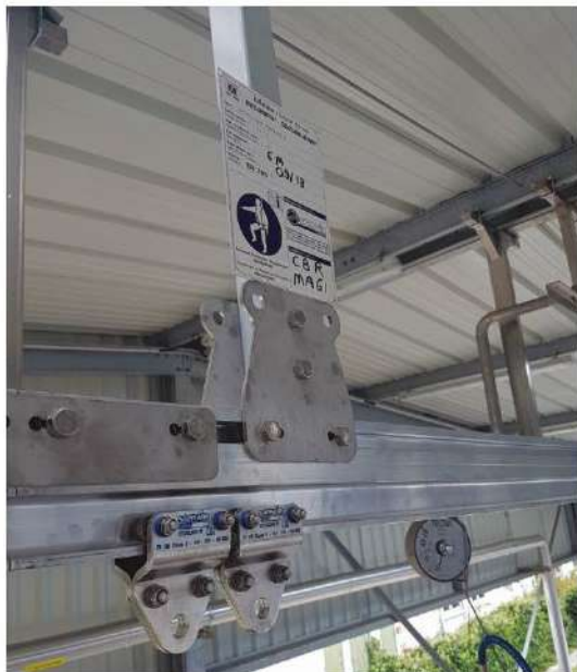
LIGNES DE VIE SUR RAIL POUR NETTOYAGE DES CITERNES Crapautage sur charpente, montage de chandelle avec adaptation de cote sur place. Rail aluminium et fixations inox.
