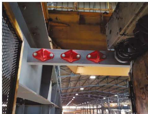
Fabrication spéciales : 3 points d'ancrage pour échelle d'évacuation à corde
